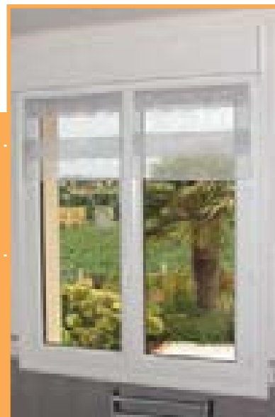
Pose en rénovation avec couvre-joints moulurés et volet roulant monobloc.
