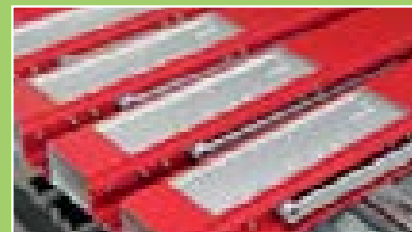
Ferme-portes intégrés dans les traverses d'ouvrants.
