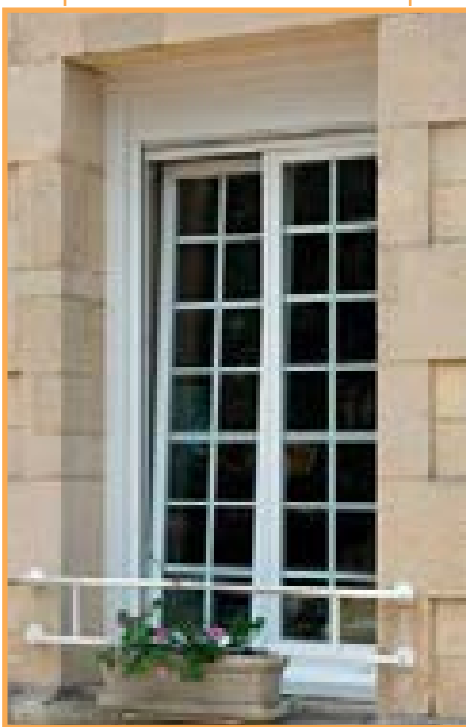
Volet roulant monobloc, coffre sous linteau et petits bois 26 x 8.
