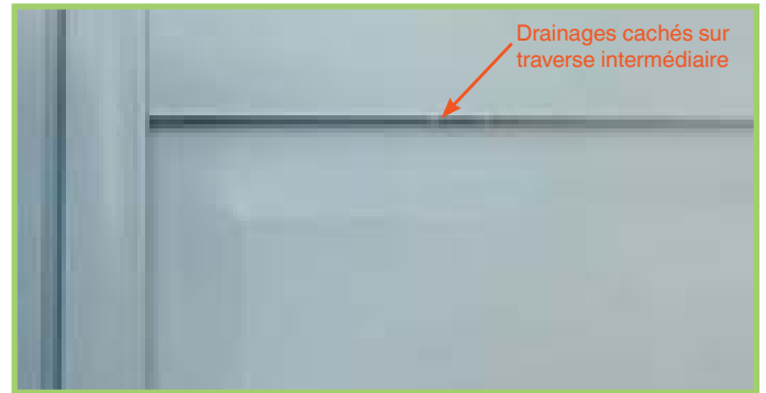
Panneau à plate-bande isolé aluminium laqué. Drainages cachés sur traverse intermédiaire
